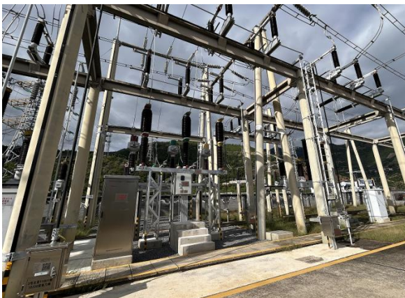
新增 110kV 主变架空进线间隔
