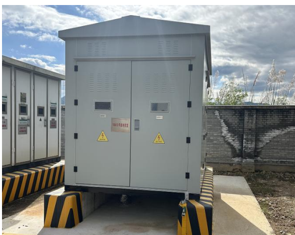
新增 10kV 接地变消弧线圈成套装置
