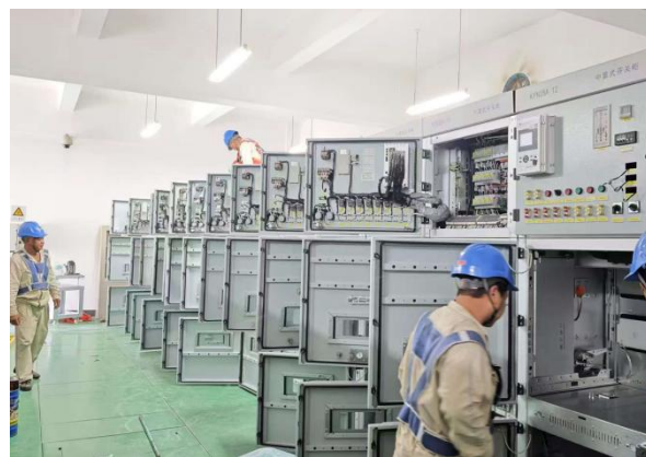
新增 10kV 金属铠装移开式高压开关柜
