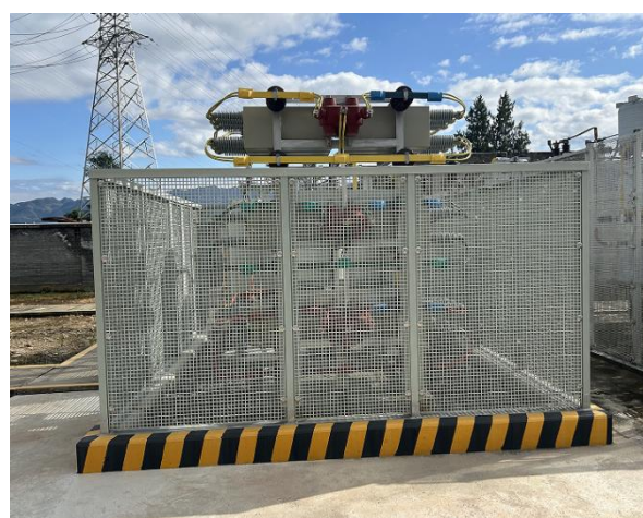
新增室外框架式电容器组成套装置
